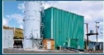
13 Station de traitement d'eau de Vangorda
