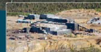
5 Secteur de l'usine de traitement – Station de traitement d'eau de Faro
