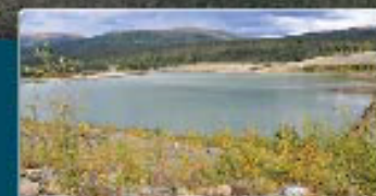
4 Bassin et barrage de Cross Valley
