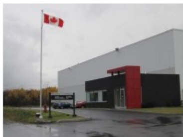
RTC Laval – Entrepôt à Laval
